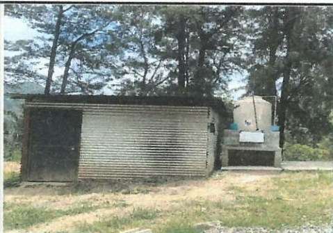
Foto 1: Mejoramiento e instalación de hileras de block y malla, solera de humedad con columnas de concreto, así mismo mejoramiento de cubierta de techo a lámina troquelada calibre 26 y mantenimiento de estructura portante.
