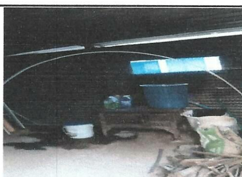
Foto 4: Instalación de Estufa ahorrativa de leña y polletón.
