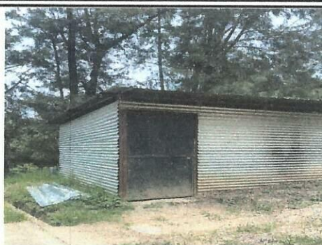
Foto 2: Remozamiento de puerta metálica
